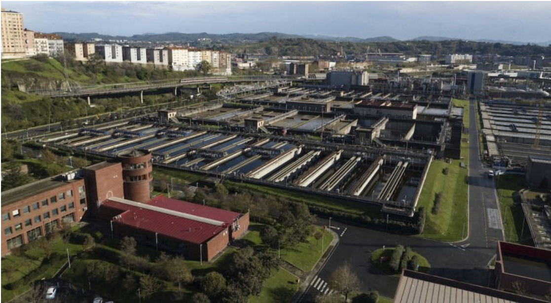
Imágenes aéreas de la EDAR de Galindo en Sestao, gestionada por el Consorcio de Aguas de Bilbao Bizkaia.
