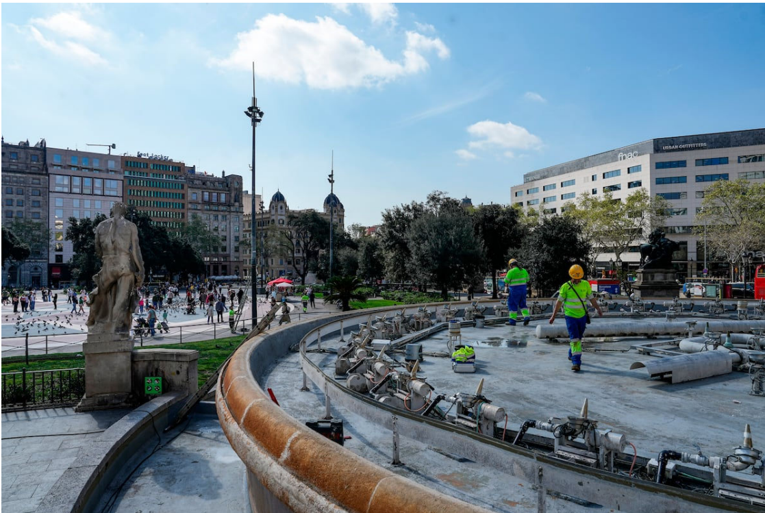
Operarios realizan tareas de reparación en las fuentes de Plaza Catalunya, que este miércoles han recuperado la circulación de agua. Enric Fontcuberta (EFE)
