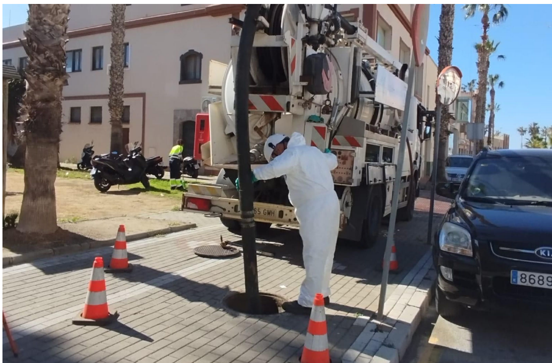
Inspección y limpieza de imbornales en Salobreña / G.H.
