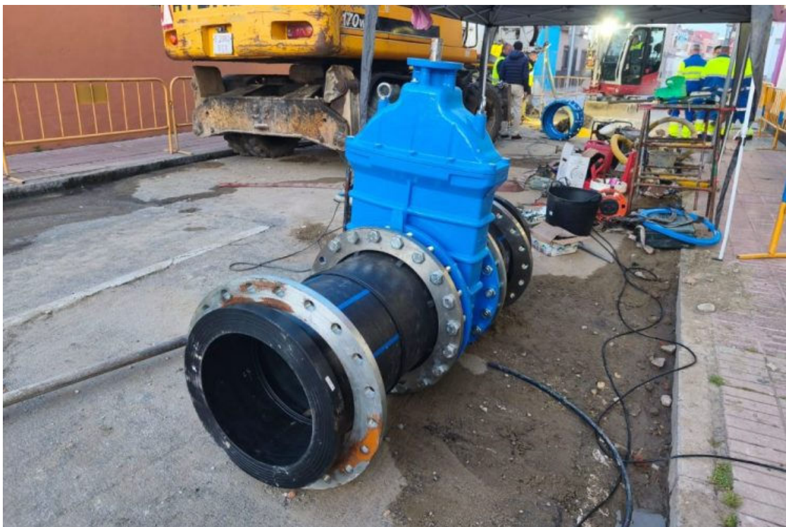
Válvula que están sustituyendo en La Línea por operarios de Aqualia y ARCGISA. / ARCGISA
